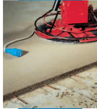
Topcem şapın yüzeyinin perdah makinesi ile düzeltmesi
