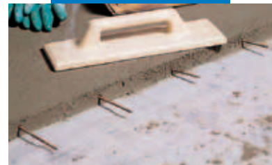
Demir donatı yerleştirilmiş Topcem şap detayı
