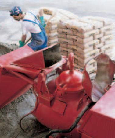
Topcem'in otomatik pompa ünitesinde karıştırılması
