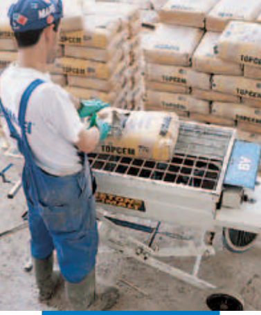
Topcem'in mini harç makinesinde karıştırılması
